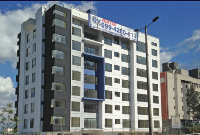
VISTA DEL EDIFICIO
